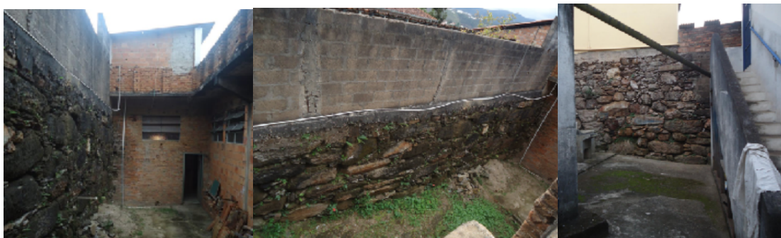
Figuras 6, 7 e 8: Estruturas da mineração no bairro do São Cristóvão em Ouro Preto - Mundéus.
