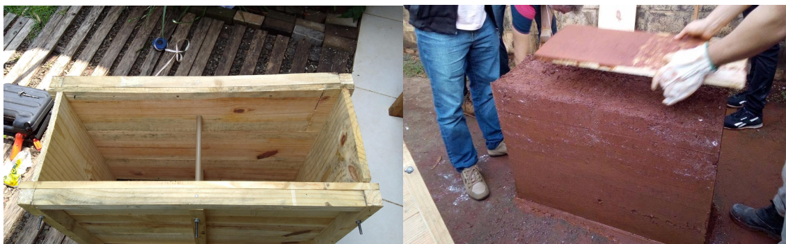
Figura 5: Forma Taipa de pilão e execução de teste na Unila
