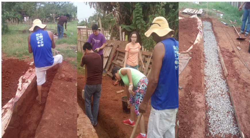
Figura 4: Etapas de produção da fundação em solo cimento
